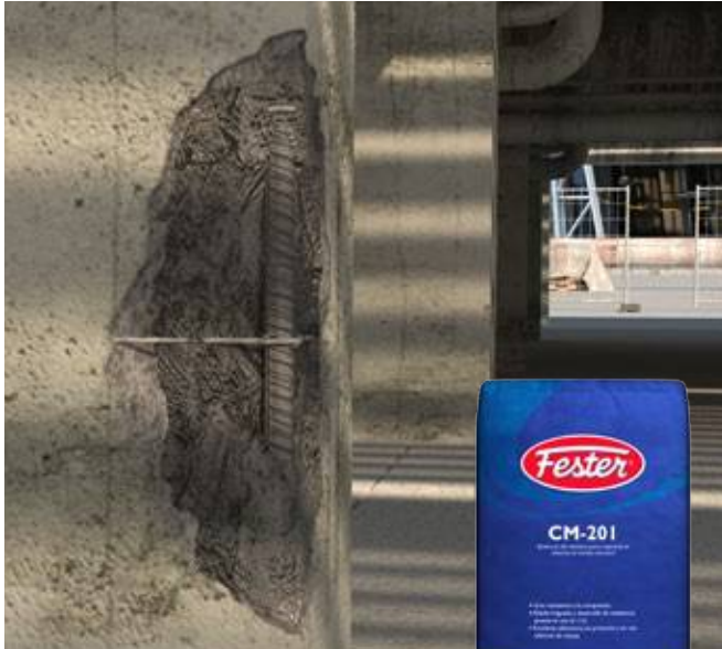
Reparación con Fester CM-201
