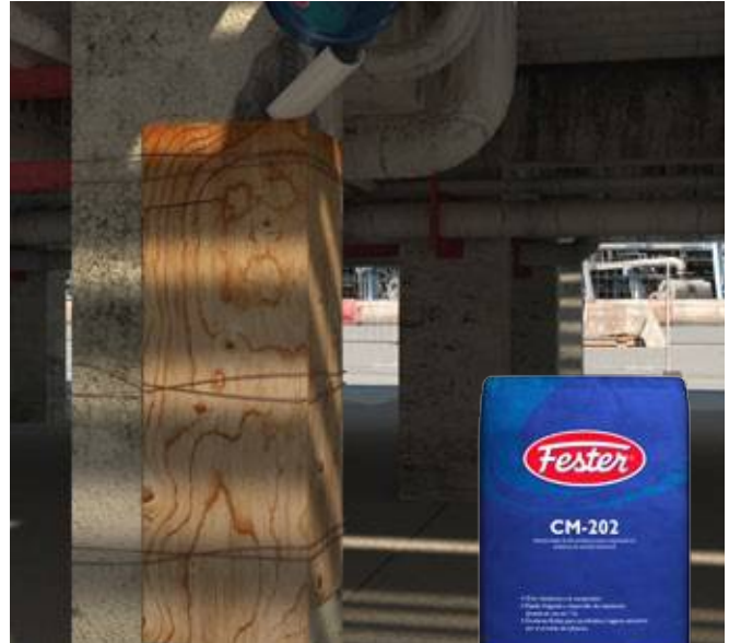
Reparación con Fester CM-202
